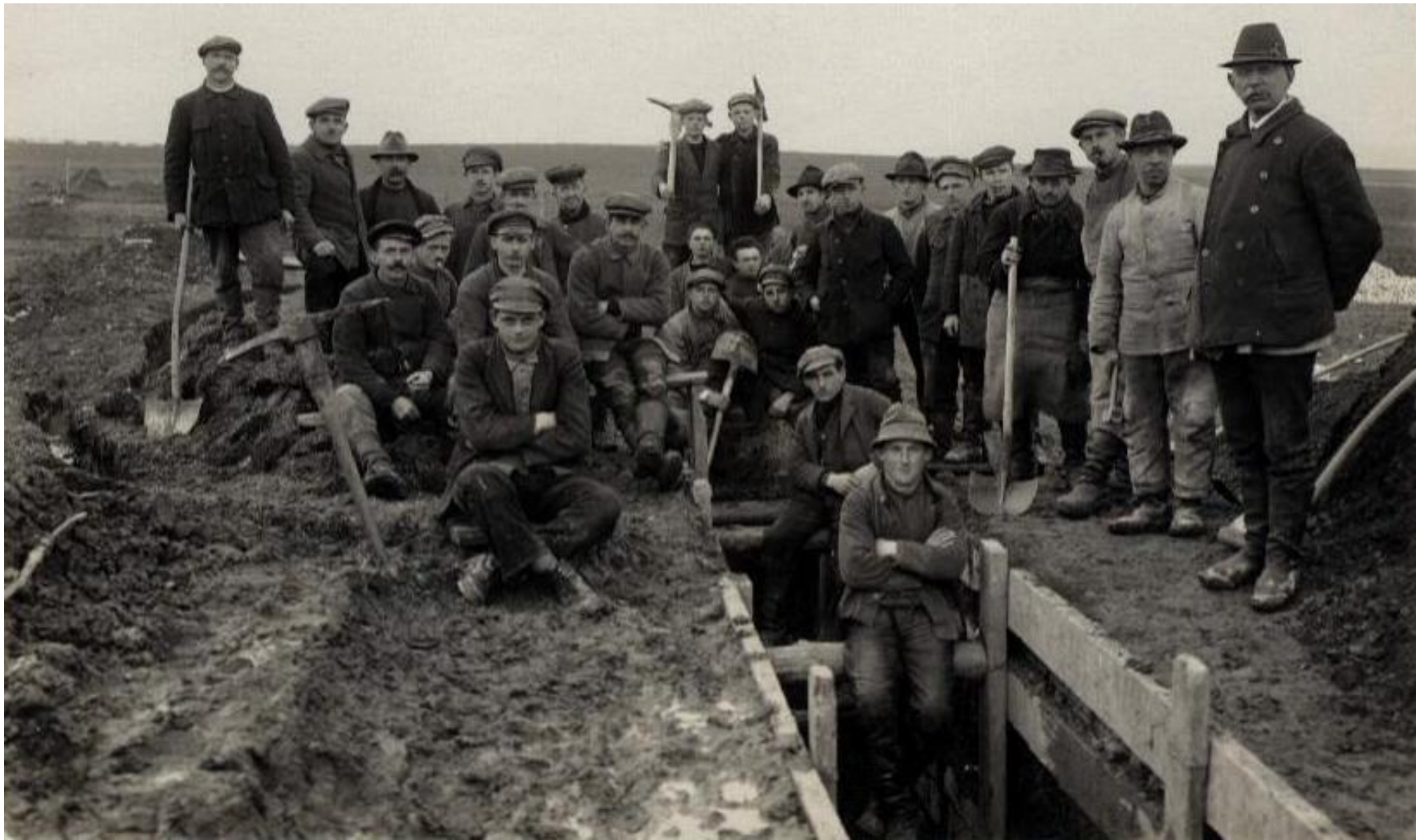
Bild vom Bau unserer Wasserleitung 1925
