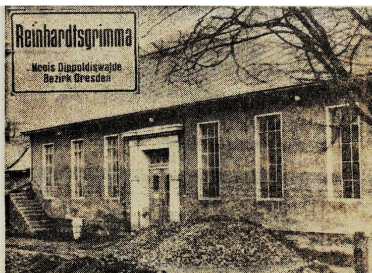
Vom Bürgerfleiß kündigt die neue Turnhalle in Reinhardtsgrimma.
